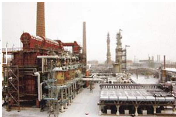
Установка каталитического риформинга с периодической регенерацией на Омском НПЗ
