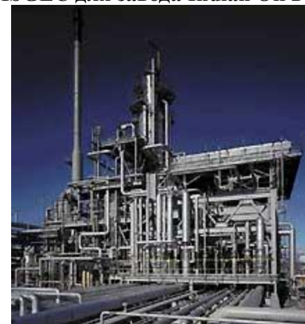
Установка гидроочистки дизтоплива на заводе British Petroleum в Грандмуте.
